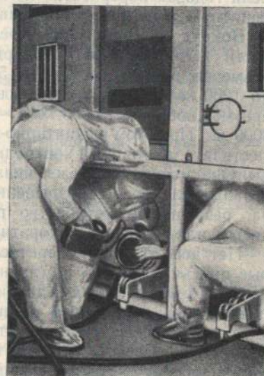
Рис. 46. Ремонт оборудования, загрязненного радиоактивными веществами. Работающие одеты в пневмокостюмы.
